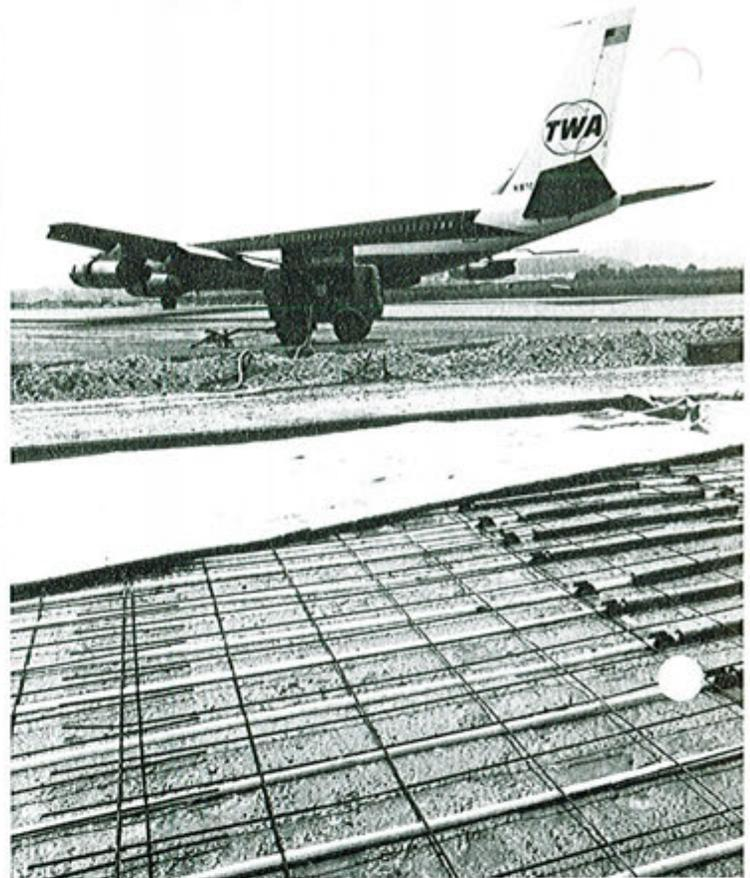
Maximale Belastung bis 30 KN/m<sup>2</sup>
