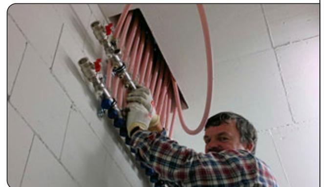
Verteilermontage unter der Decke
