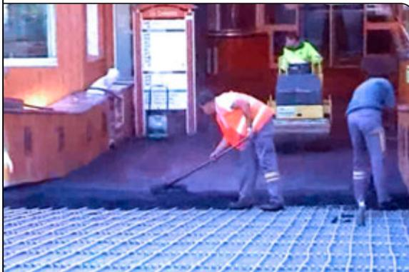
*Verlegung des Asphalts auf den MB-Rohren*
