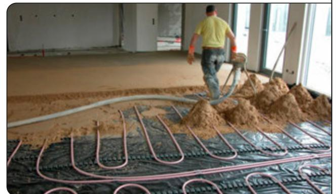
Einbringung des Anhydritestrichs auf den Heizrohren
