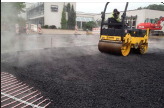
Verdichtung des Asphalts mit der Walze
