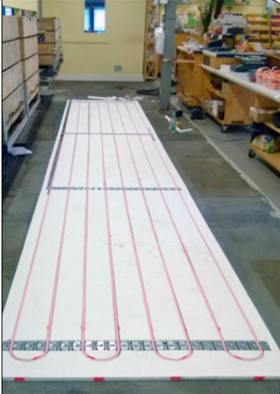
Unterboden aus MULTIBETON Euro-Systemrohr 12, den Clipsschienen und Druckverteilerplatten
