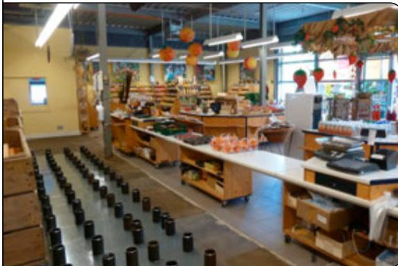
Der gerade verlegte MULTIBETON-Fertigboden S18 ist mit Gewichten beschwert, bis der Kleber ausgehärtet ist
