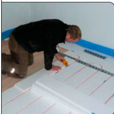
Verlegung des MB-Fertigbodens S18
