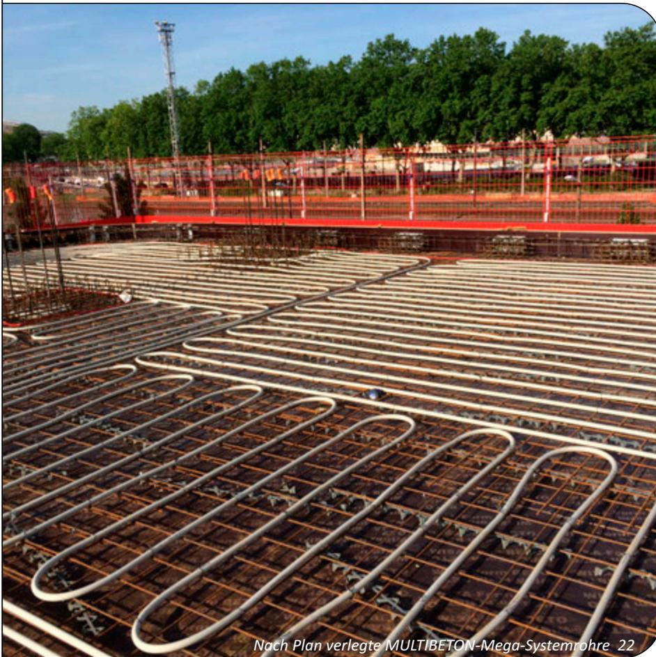
Nach Plan verlegte MULTIBETON-Mega-Systemrohre 22
