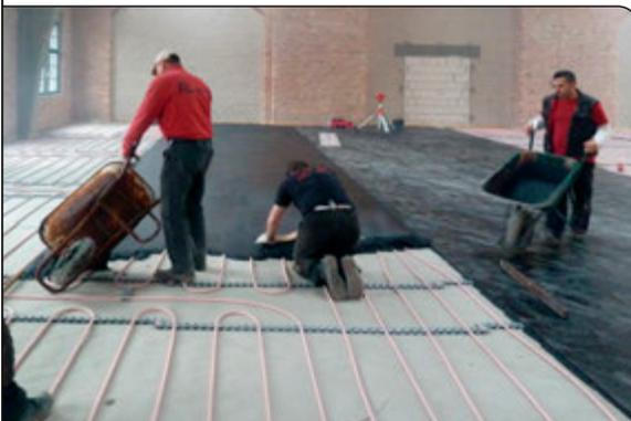
Asphaltverlegung auf dem MB-System
