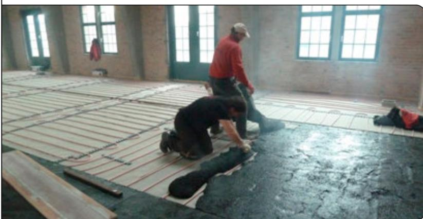
Einbringung des Gussasphalts
